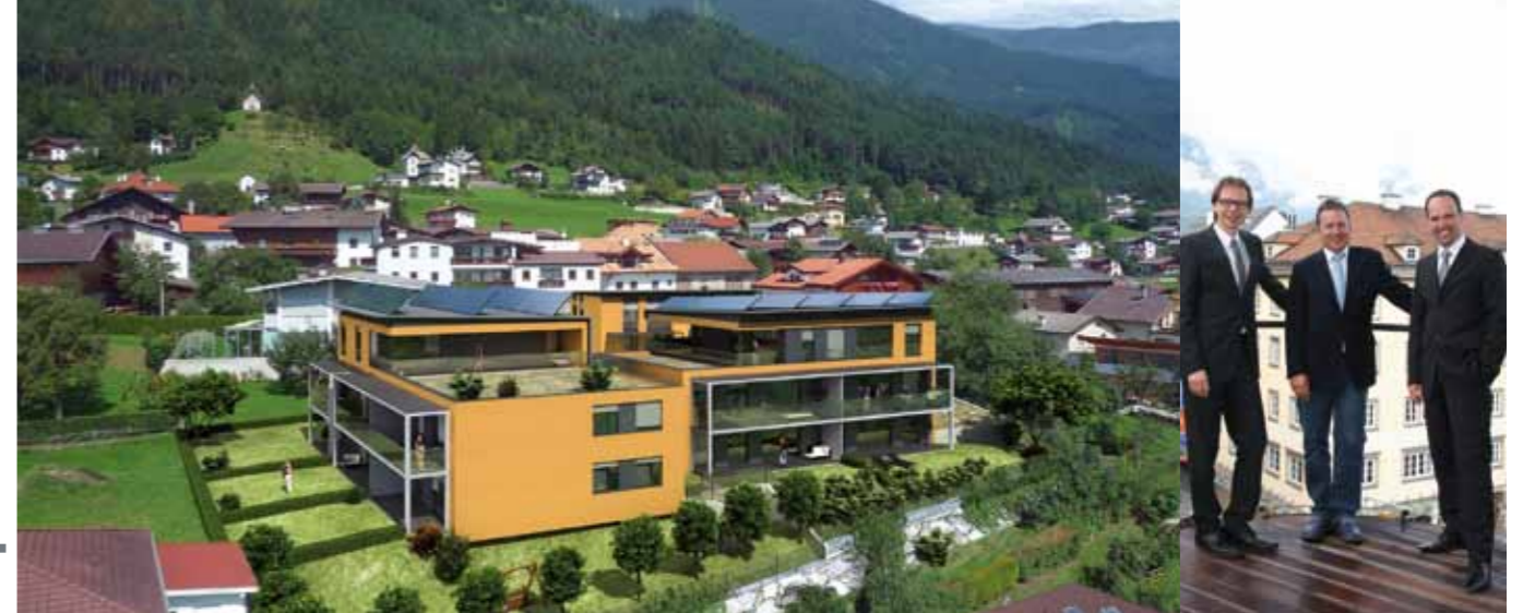
Die kleine, feine und vor allem energie- und bautechnisch zukunftsweisende Wohnanlage „Moargarten“ in Vomp
